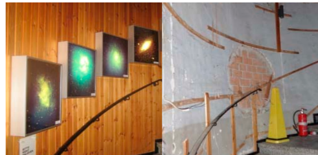
Der Rückbau ist bereits in vollem Gange. Alle Oberflächen sind betroffen.
